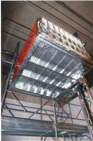
La struttura in lamiera sagomata e forata oltre a essere parte strutturale diventa un piano di calpestio rigido e antisdrucciolo, la zincatura per immersione a caldo mantiene inalterata nel tempo la superficie evitando così manutenzione e sostituzione del piano stesso. Rampe e ribaltina di montaggio usano lo stesso sistema costruttivo e di trattamento superficiale.
