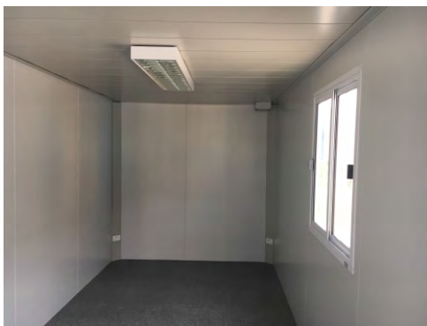
Impianto elettrico a scomparsa , nessuna canaletta nelle pareti.
